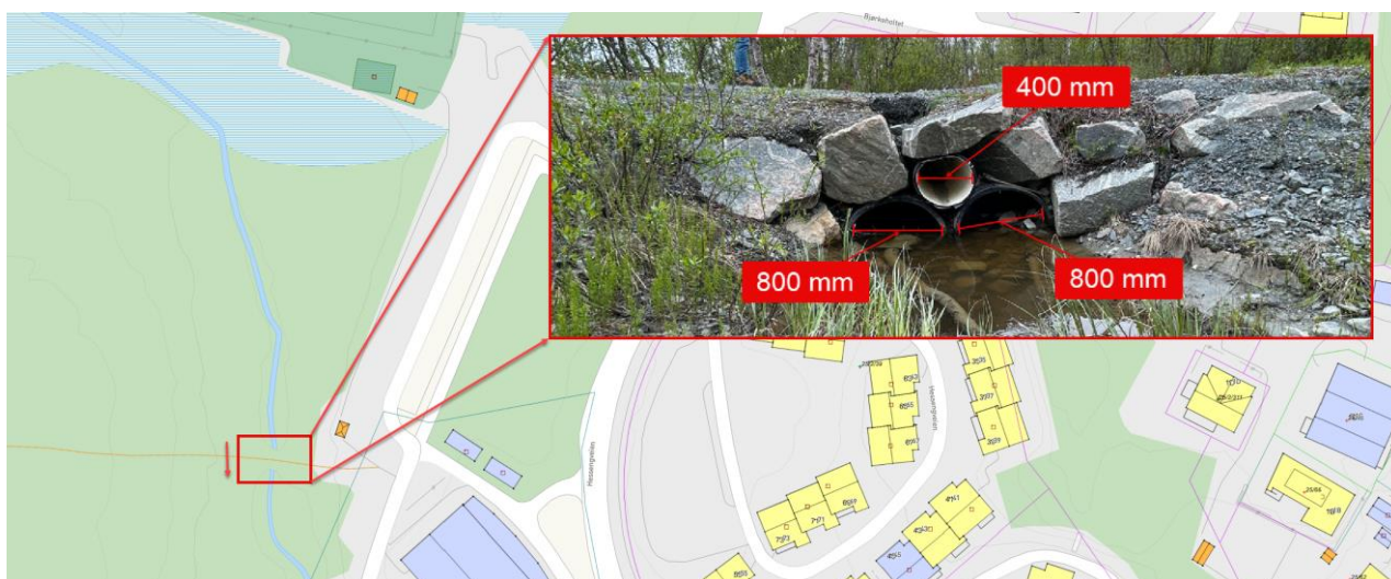
Figur 2-2: Stikkrenner etablert i forbindelse med kryssende sti i Portvinsbekken. Sett oppstrøms og nedover.
