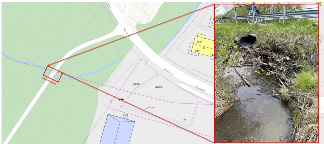
Figur 2-9: Kulvert og stikkrenne under Tangenveien. Sett oppstrøms og nedover.
