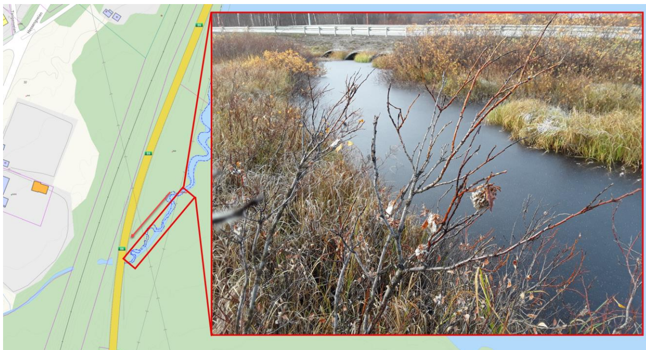
Figur 2-19: Nedstrøms stikkrenner E6. Sett nedstrøms og oppover.
