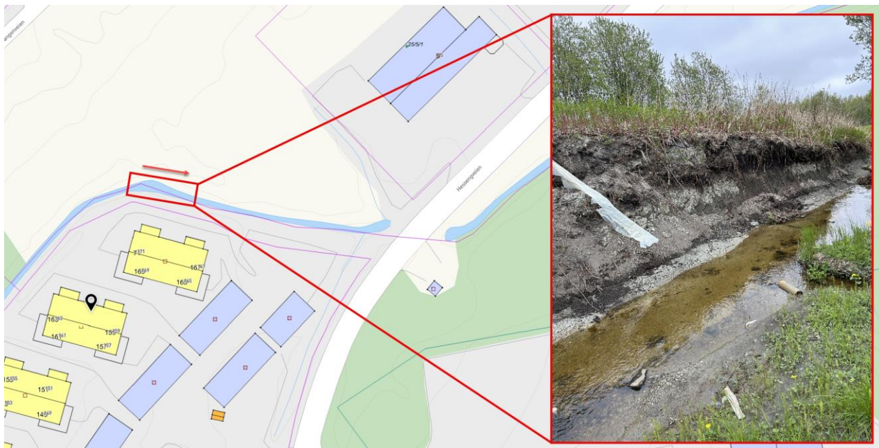
Figur 2-13: Bakovergrepene graving (erosjon) av ytterkurven bekkeløp. Sett oppstrøms og nedover.
