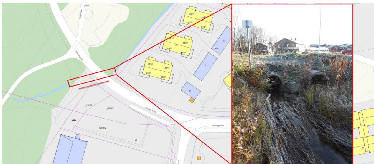
Figur 2-10: Stikkrenner under Hessengveien. Sett oppstrøms og nedover.
