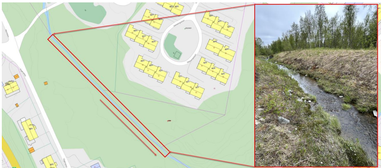
Figur 2-7: Portvinsbekken etter erosjonssikring. Sett oppstrøms og nedover.
