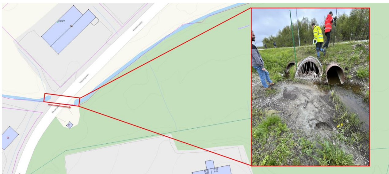
Figur 2-14: 800 mm stikkrenner av stål og kulvert 1200 mm betong som krysser Hessengveien. Sett oppstrøms og nedover.
