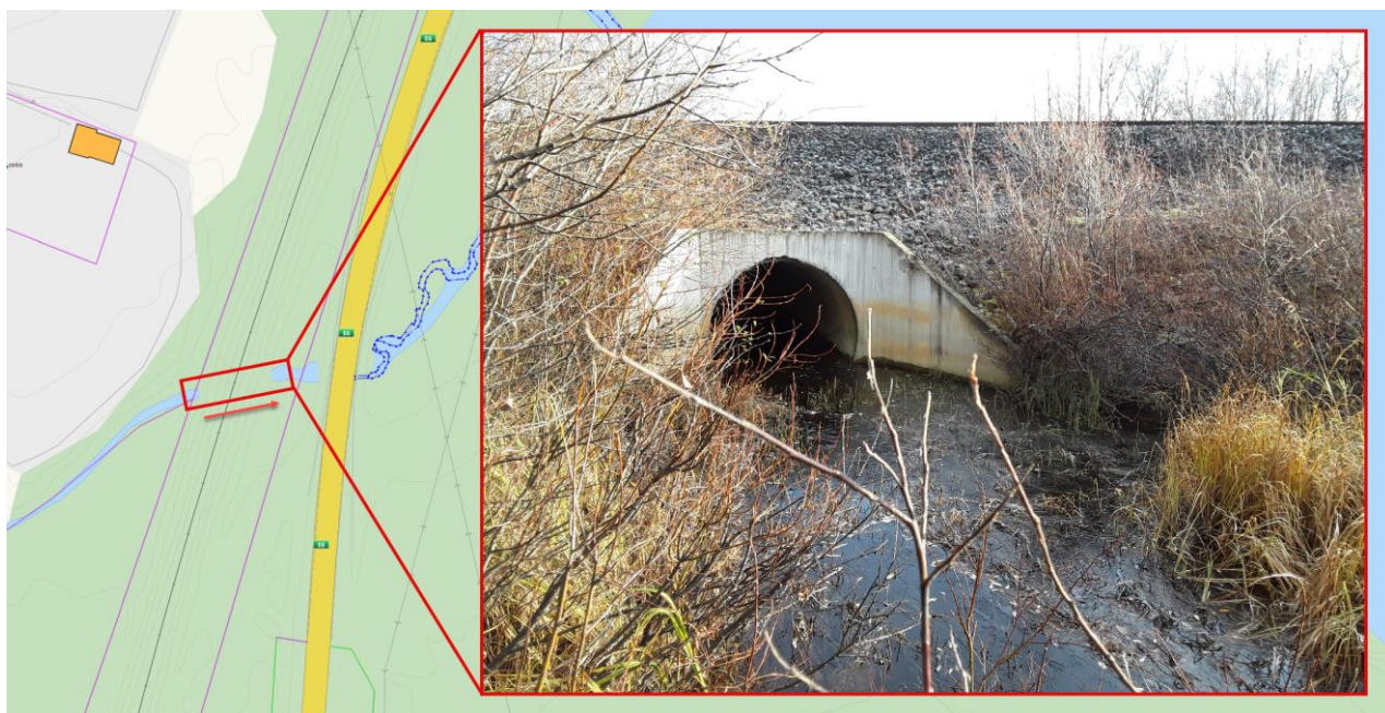
Figur 2-17: Jernbanekulvert, 2000 mm med vingemur. Sett oppstrøms og nedover.
