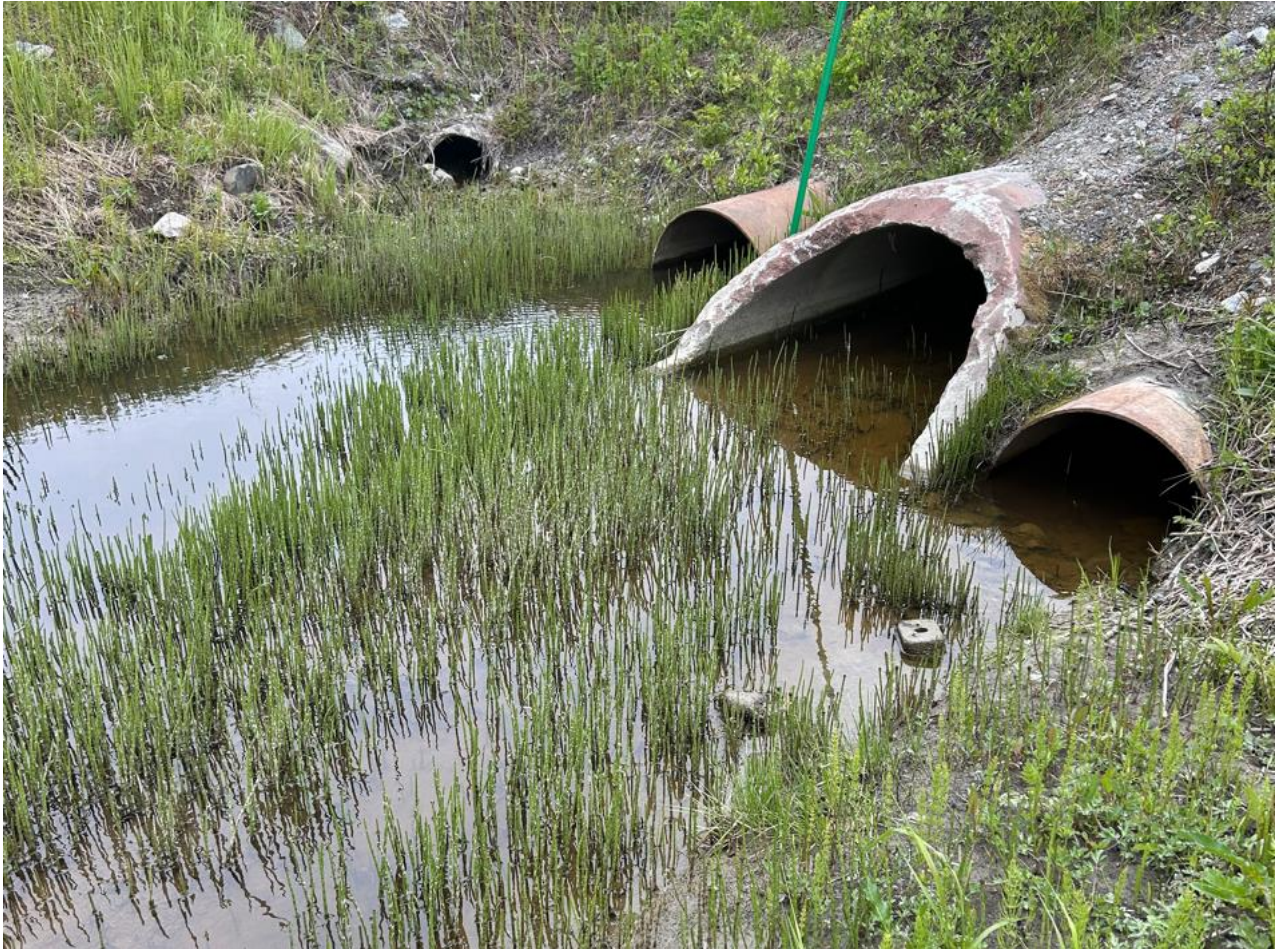
Figur 2-15: Nedstrøms stikkrenner og kulvert gjennom Hessengveien.
