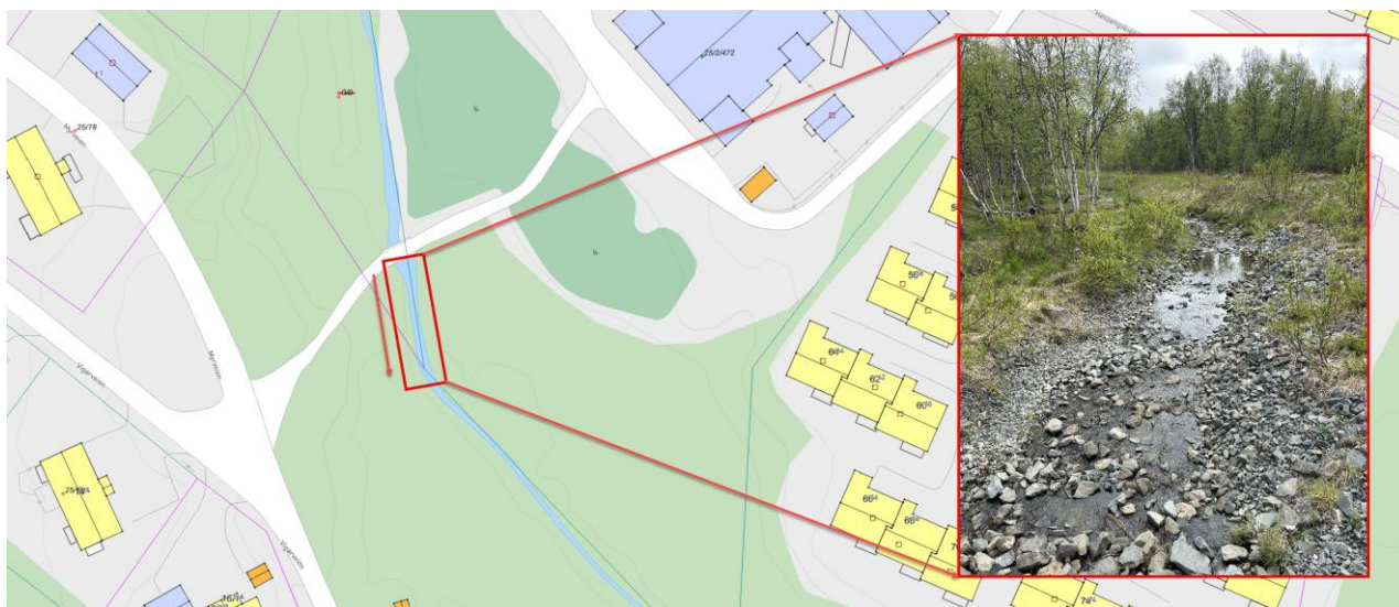
Figur 2-4: Erosjonssikring nedstrøms bro som krysser Portvinsbekken. Sett oppstrøms og nedover.
