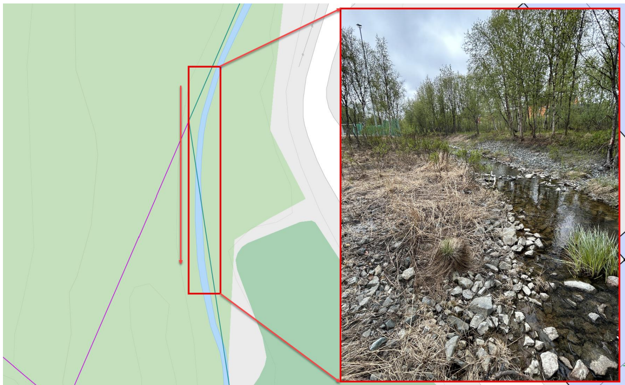
Figur 2-3: Bekkeløp vest for Hesseng Flerbrukssenter. Sett oppstrøms og nedover.
