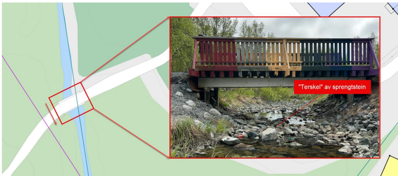
Figur 2-5: "Terskel" før bro som krysser Portvinsbekken. Sett oppstrøms og nedover.
