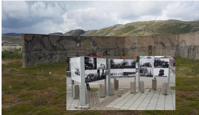
Splinthangarer skulle beskytte fly for splinter som følge av bombenedslag. Noen av disse er godt synlig på sørsiden av E6. Til sammen fantes det 10-15 av disse og 3 er bevart. Det illustrerte bildet viser hangaren og hvordan den kan benyttes i en formidlingsstrategi. Foto: Gunnar Reinholdtsen
