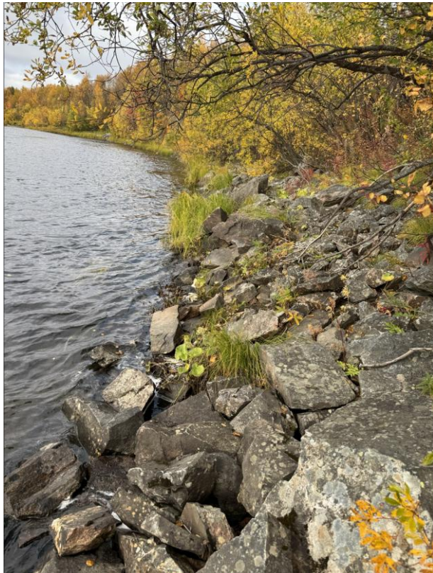
Figur 5-2: Bilder fra befaringsdagen, synlig erosjonssikring.
